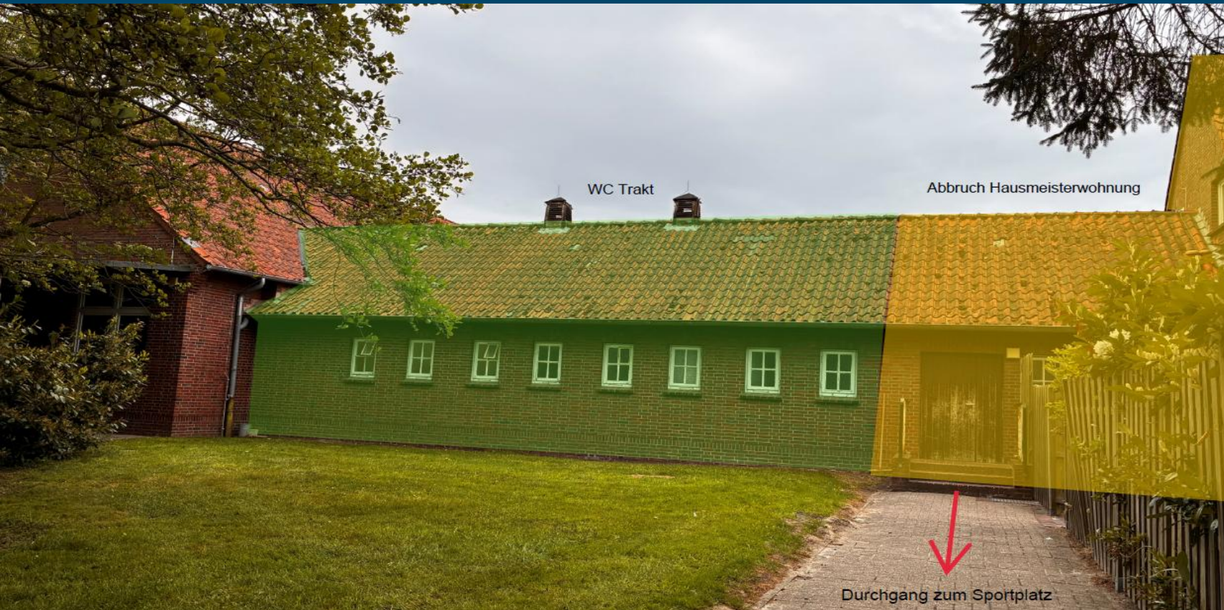
Ansicht Bestandsgebäude aus Sicht vom Sportplatz
