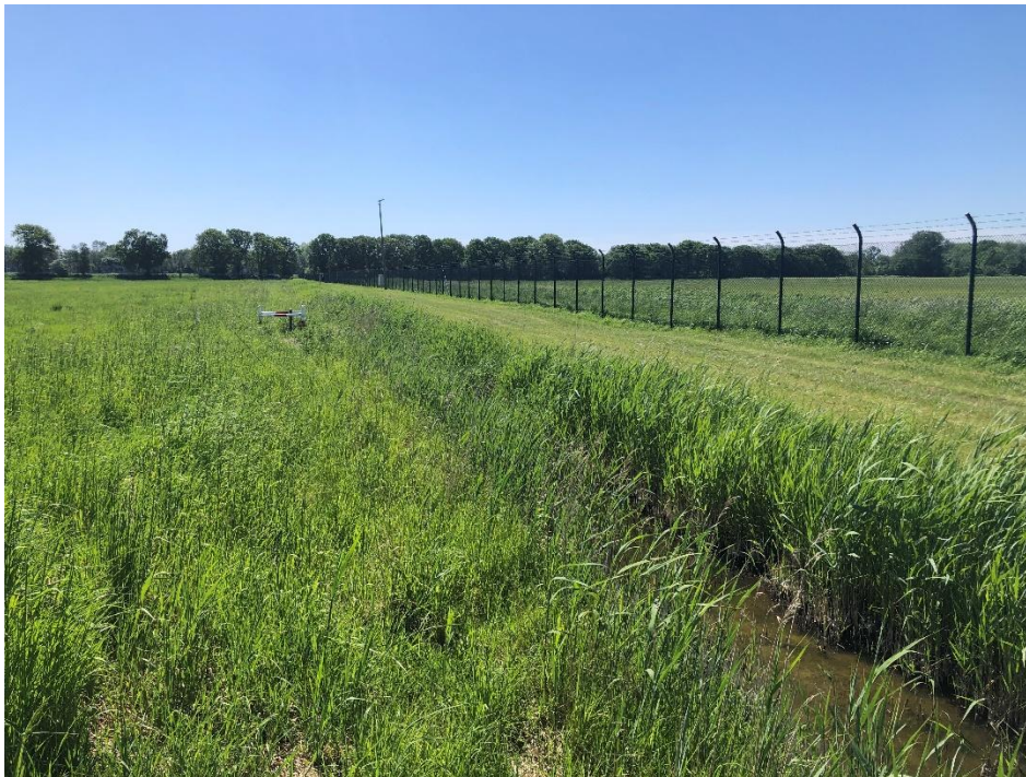
Abbildung 7: Graben am Westrand des eingezäunten Werksgeländes
