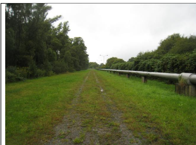
Nordseite, westlicher Bereich
