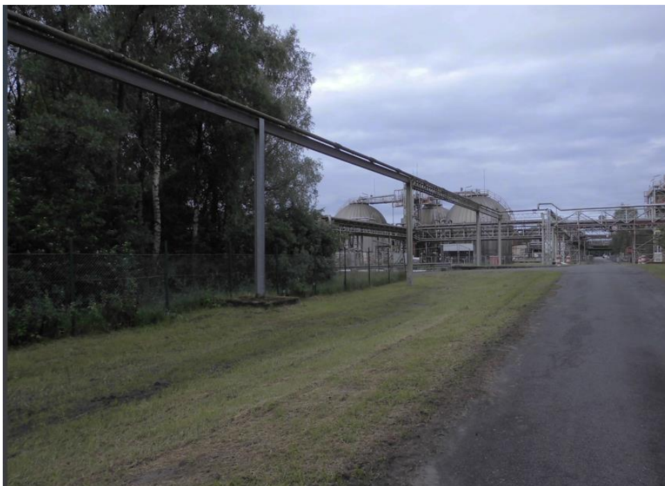
Abbildung 3 – Oberirdische Rohrtrasse
