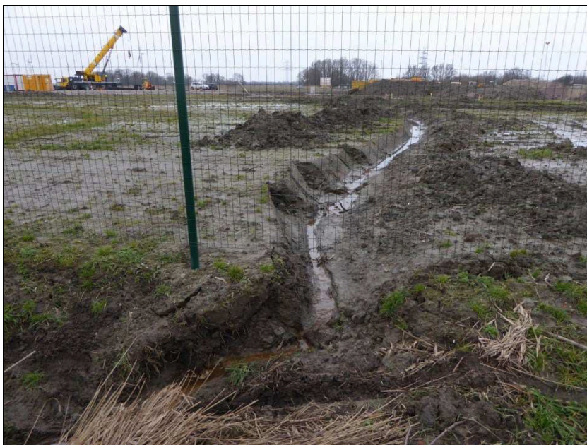
Abbildung 14: Der nördliche Baustellenbereich wird durch mehrere Stichgräben provisorisch entwässert (Quelle: von Lemm 2016).
