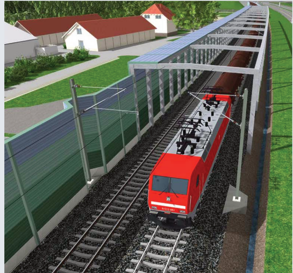
Beispiel: Geplantes Galeriebauwerk ABS Karlsruhe-Basel
